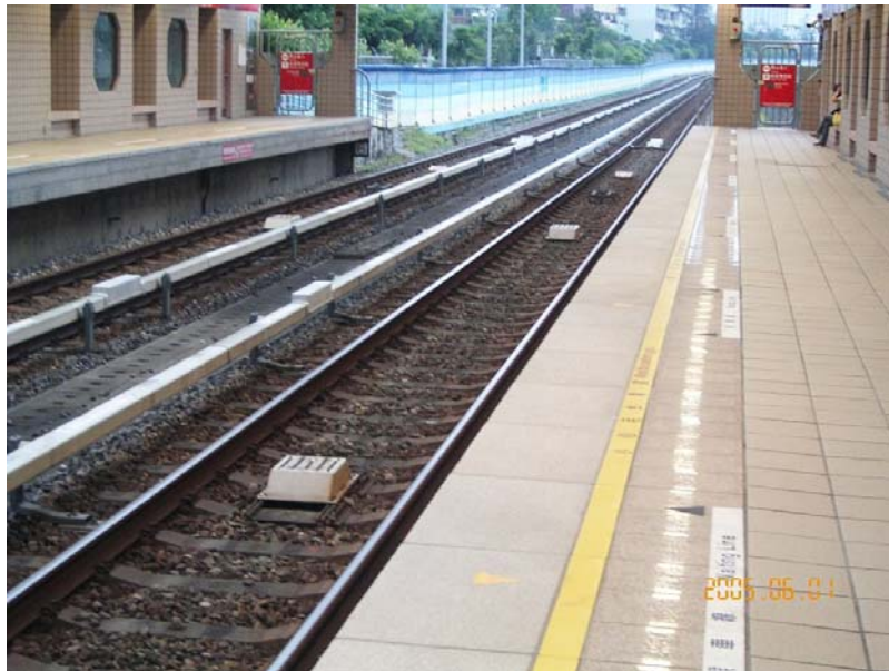
臺北捷運淡水線平面段車站
