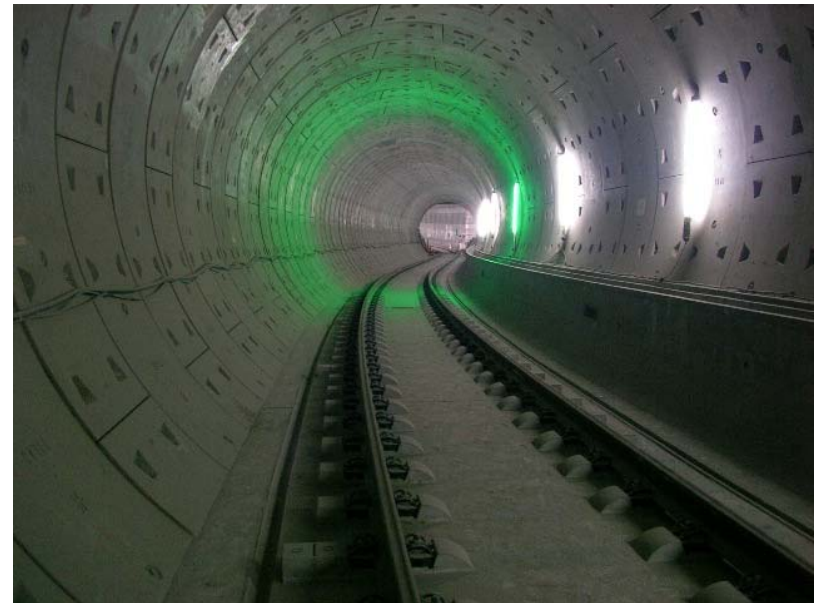
高雄捷運潛盾隧道段
