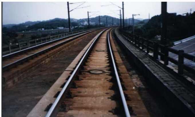
臺鐵南港溪橋
