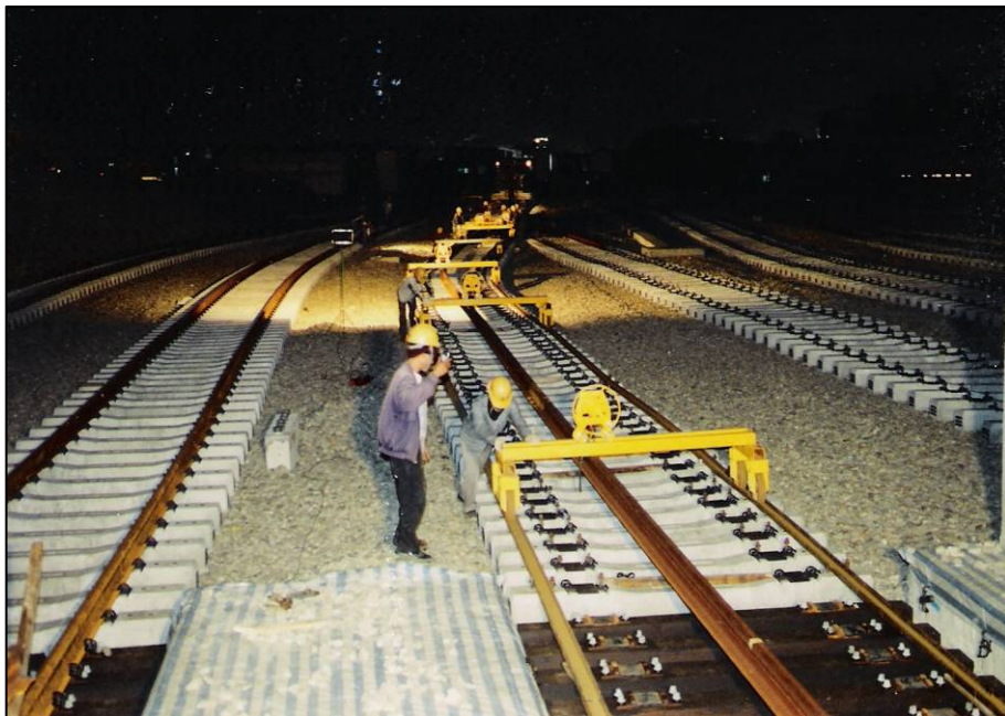
圖7 長焊鋼軌佈設
