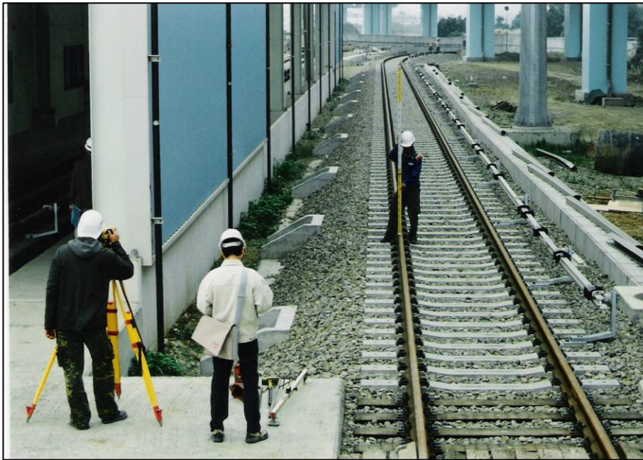
圖21 鋼軌踏面高程檢測 (量測值應在設計值 \pm 3\text{mm} )
