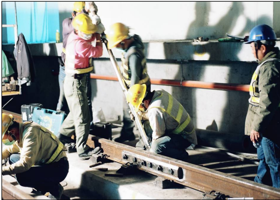
圖27 鋼軌絕緣接頭組裝
