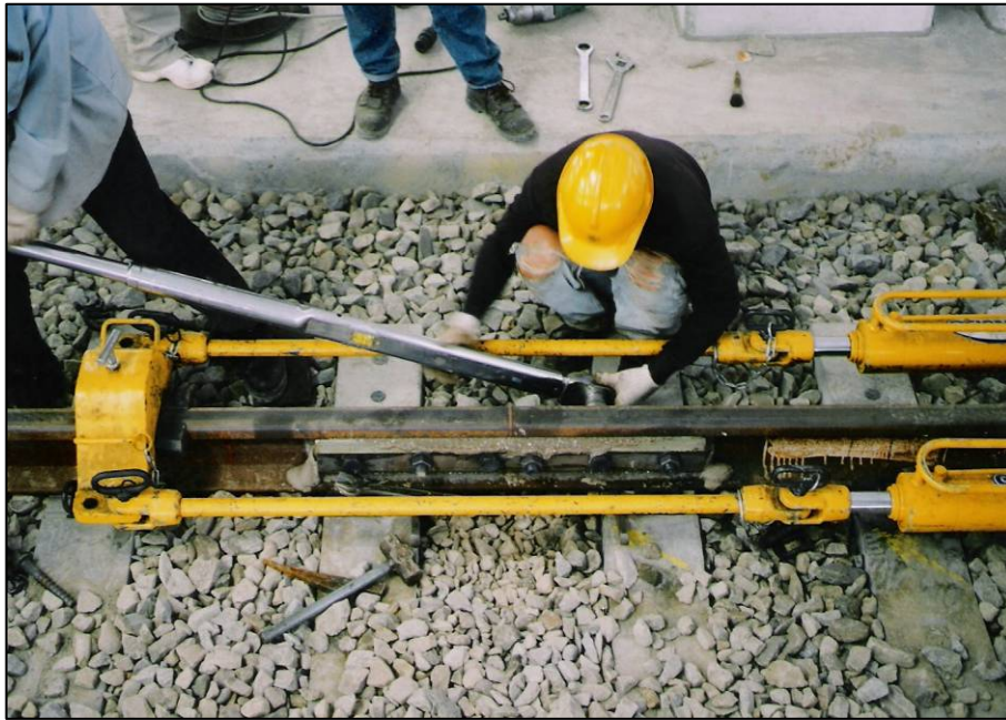
圖19 IRJ螺栓扭力值確認 (扭力值應 \geq 2000\text{Nm} )
