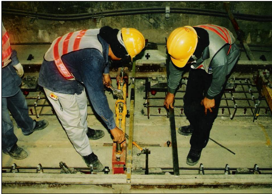
圖5 施工樣架調整與定位
