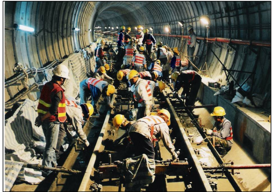
圖16 混凝土基座施築
