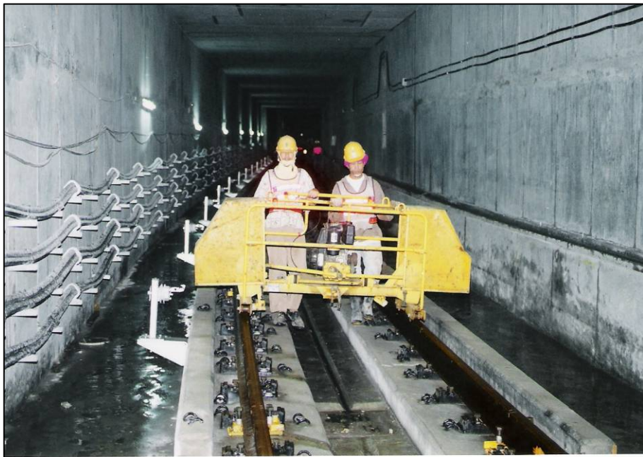
圖25 鋼軌應力解除作業
