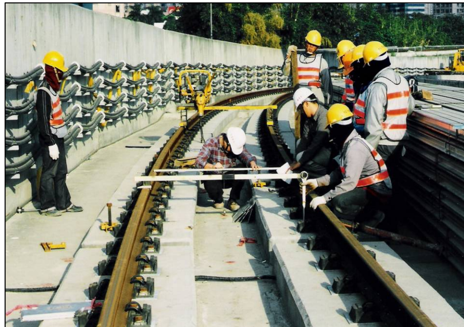
圖26 鋼軌線形調整
