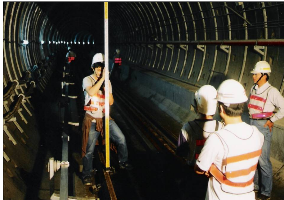
圖30 鋼軌鋪設踏面高程量測 (設計值 \pm 3\text{mm} )
