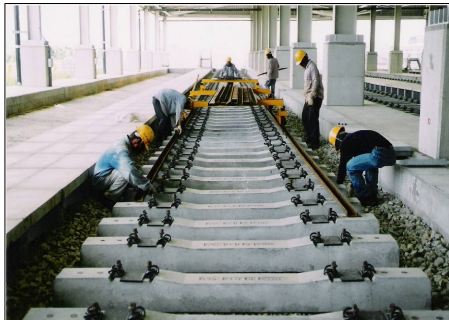
圖6 鋼軌扣件安裝
