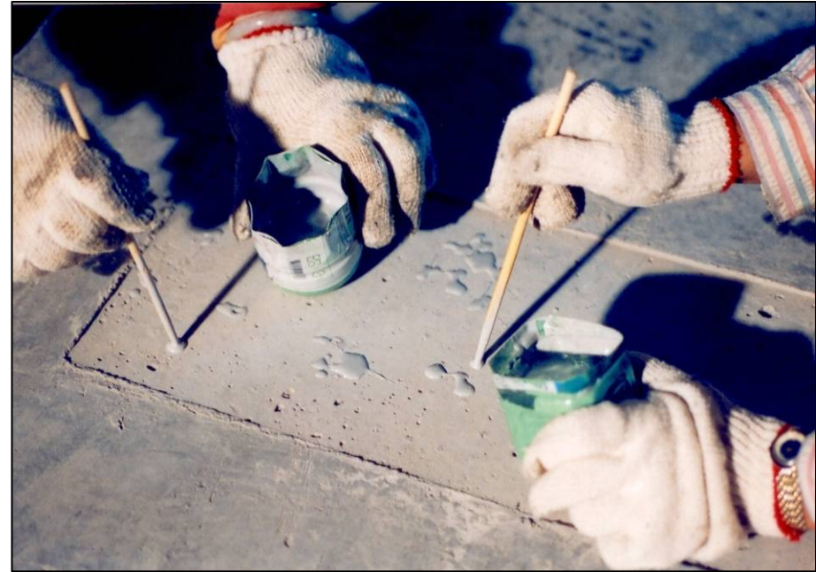
圖18 基座承載面氣孔填補
