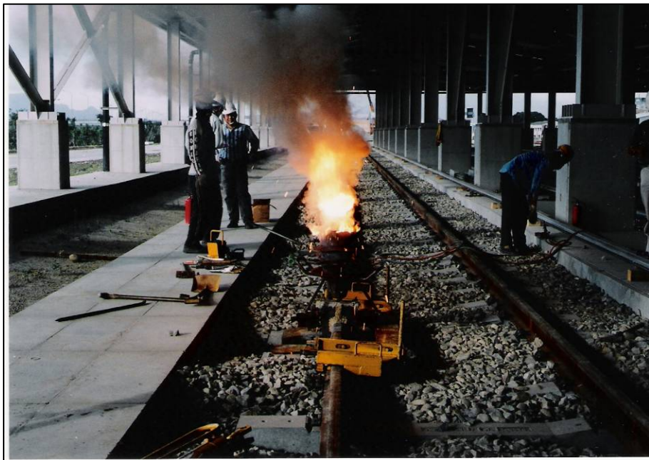
圖11 鋼軌鋁熱焊接
