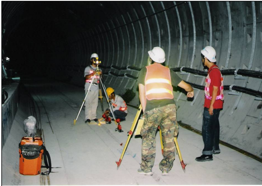
圖1 軌道中心點測量放樣
