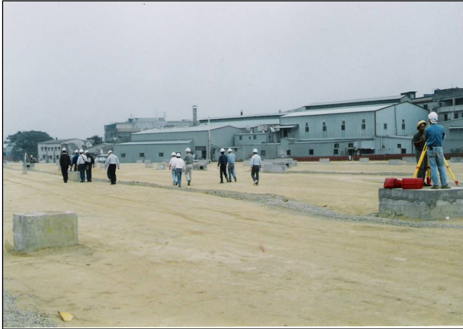
圖1 施工場地交接會勘
