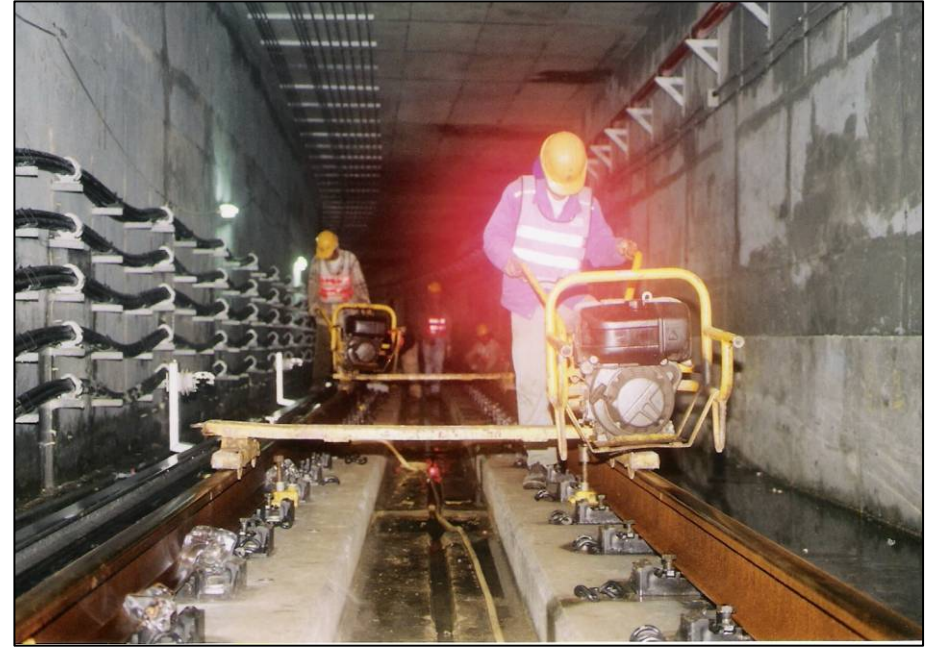
圖24 鋼軌扣件固鎖
