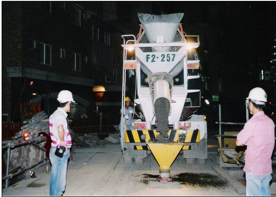
圖15 混凝土灌漿開口
