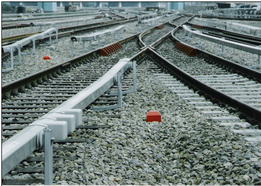
圖15 警衝標安裝完成狀態
