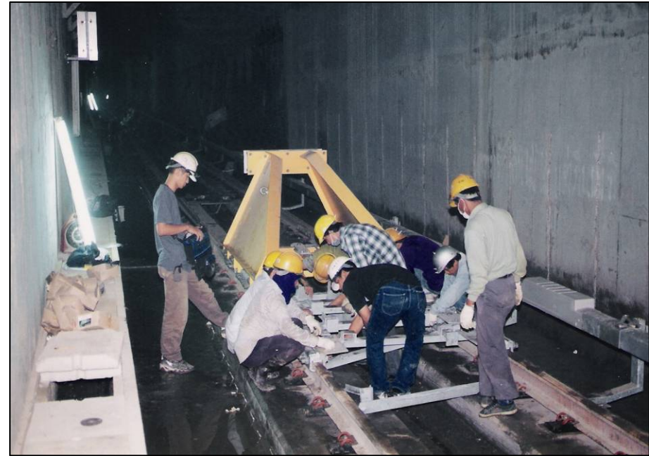
圖32 止衝擋安裝作業
