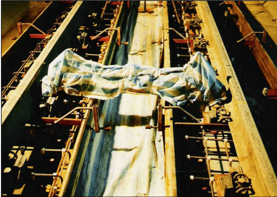
圖7 基座施築前設施保護
