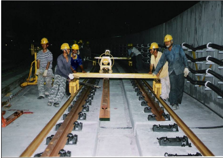
圖23 鋼軌鋪設
