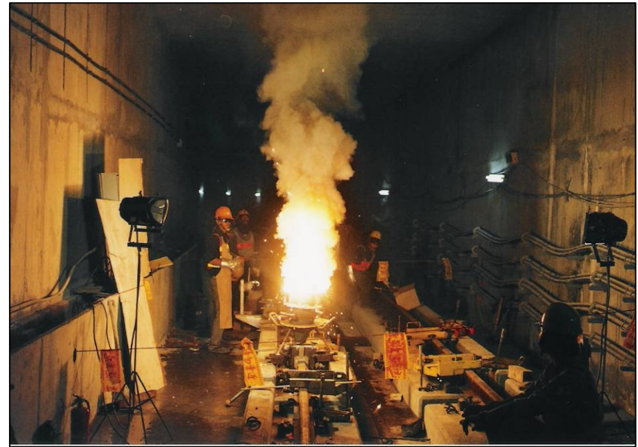
圖28 鋼軌鋁熱焊接作業
