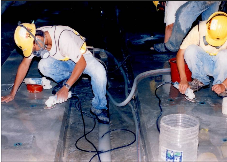
圖19 基座承載面修整
