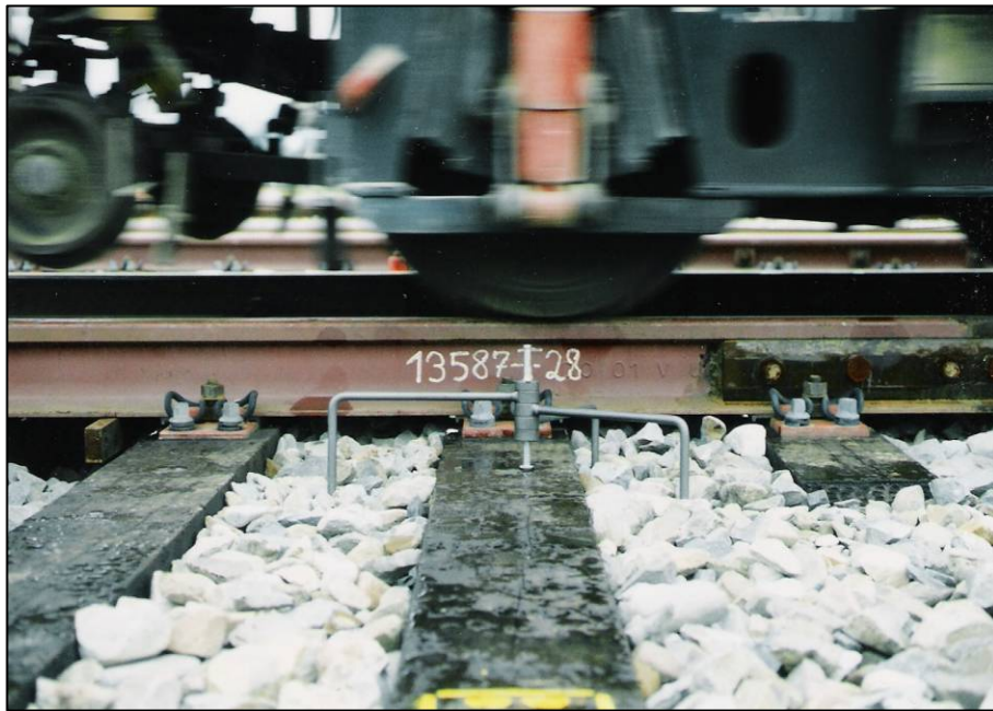
圖17 道碴夯實檢測
