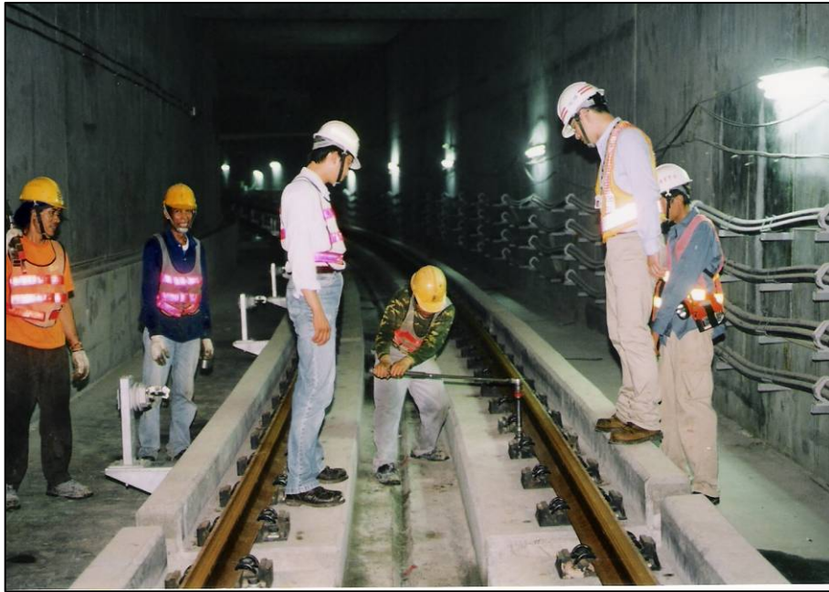
圖31 基鈹螺栓扭力值量測 (錨定螺栓： 380\pm 20\text{Nm} ) (扣夾螺栓： 220\pm 30\text{Nm} )
