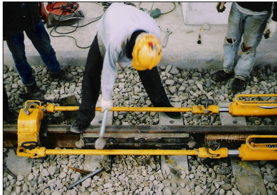
圖12 鋼軌絕緣接頭安裝
