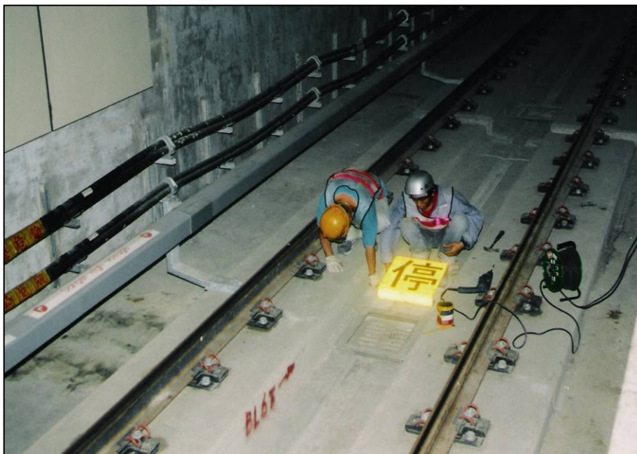
圖33 軌道標誌安裝
