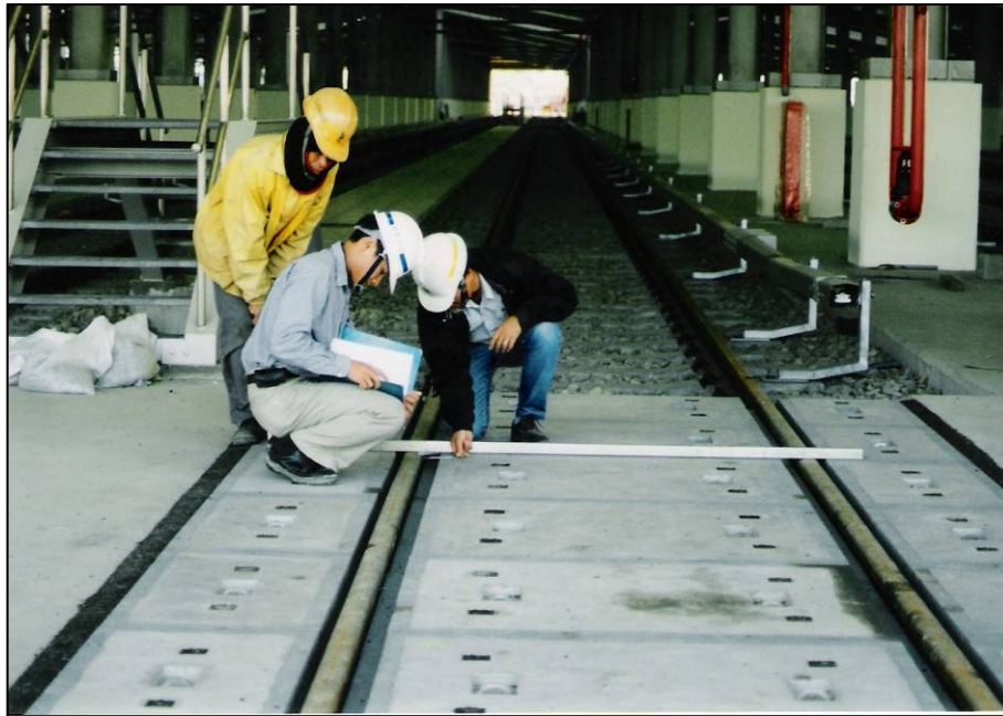
圖29 平整度量測 (完成面在鋼軌踏面下 +0/-6\text{mm} )
