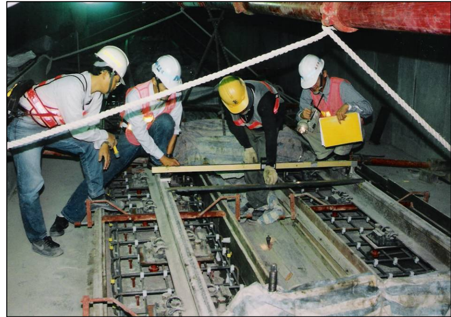
圖10 基座中心點檢測
