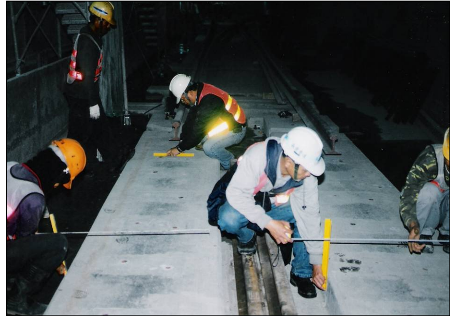
圖20 混凝土基座施築後查驗 (基座寬度 900\pm 20\text{mm} )
