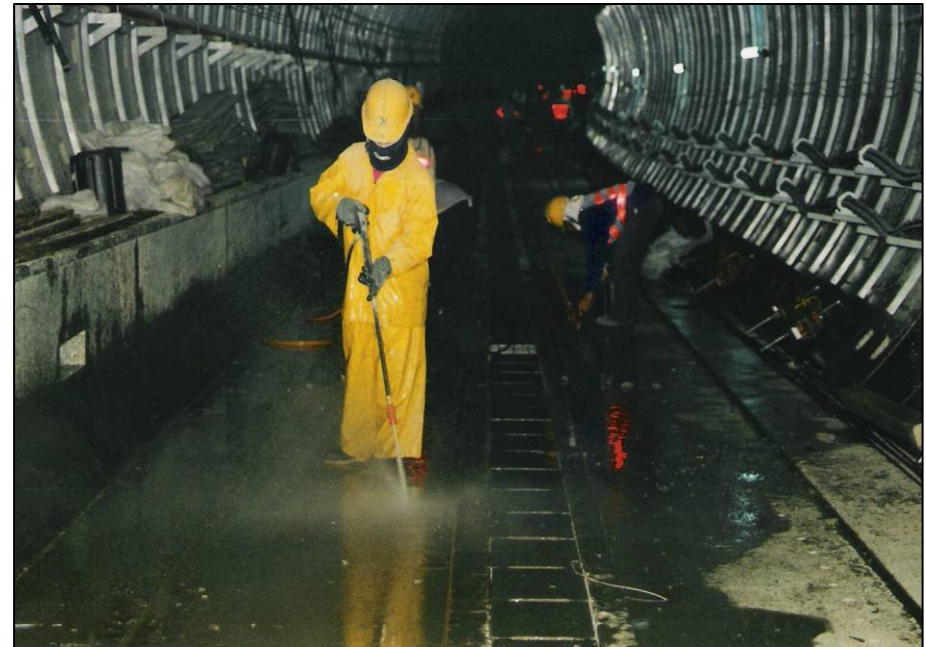
圖2 隧道仰拱面清理
