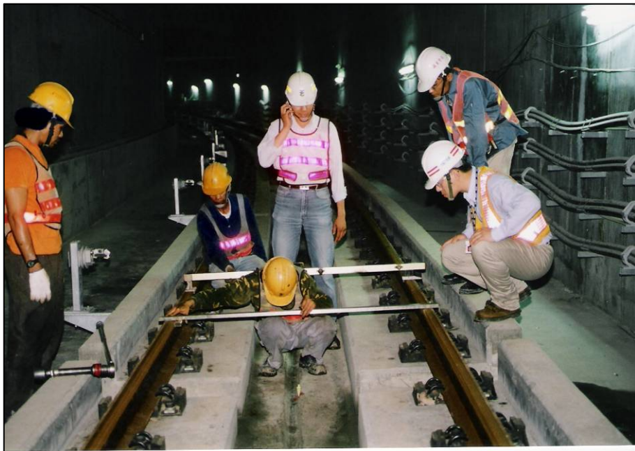
圖29 軌道中心點及軌距量測 (軌道水平偏移量控制在 \leq \pm 3\text{mm} ) (軌距： 1435 \pm 1.5\text{mm} )
