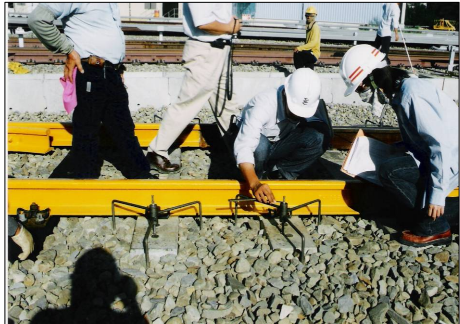
圖28 道碴夯實檢測
