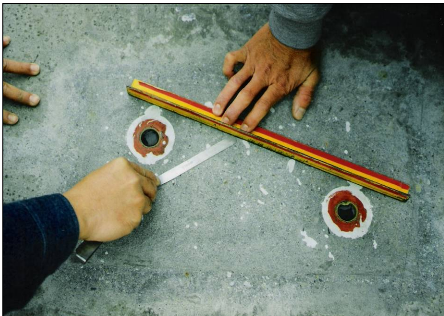
圖21 基座承載面平整度查驗 (承載面400mm範圍內 \leq 0.5\text{mm} )
