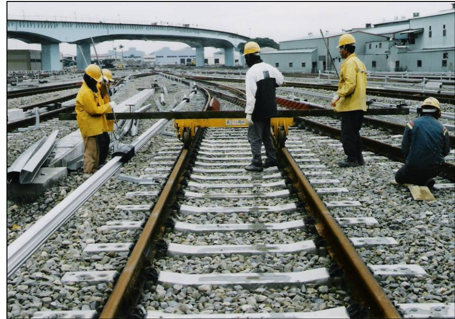
圖26 道床斷面量測
