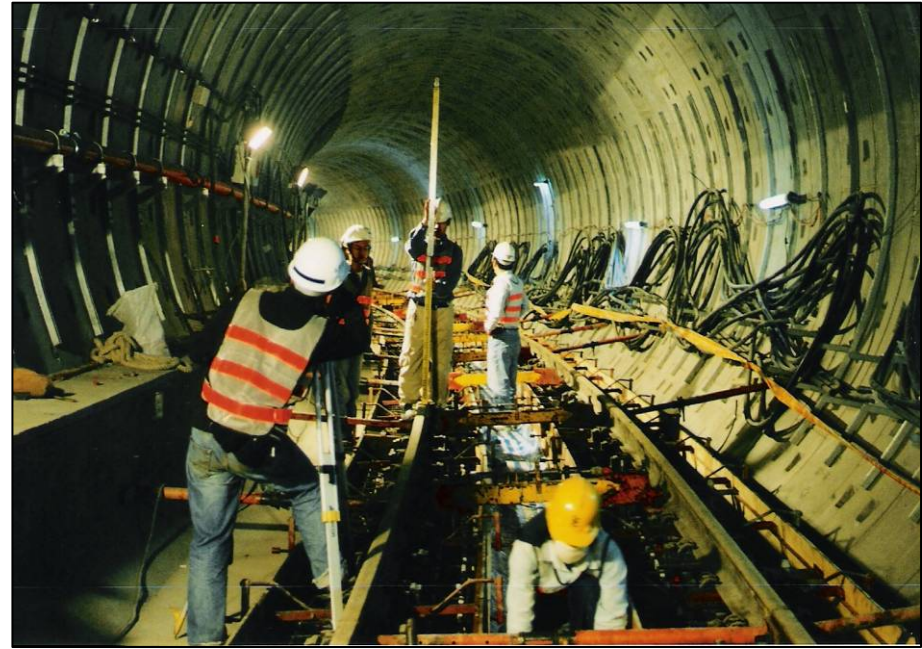
圖14 鋼軌踏面高程調整 (設計值 \pm 3\text{mm} )
