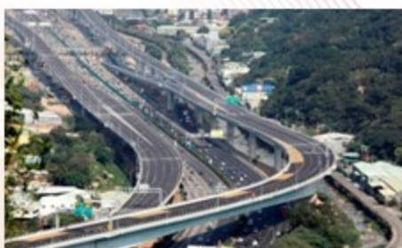
國道1號 C901標五股泰山段北上線工程
