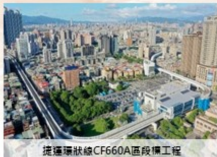
捷運環狀線CF660A區段標工程
