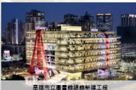
高雄市立圖書館總館新建工程
